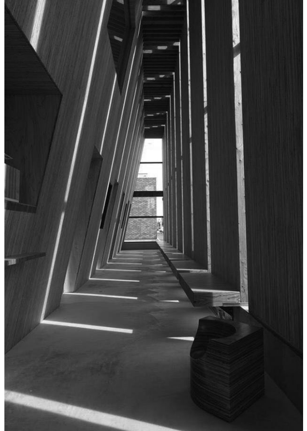
図4 みやむら動物病院 LVL 厚板による 準耐火建築のプロトタイプ
