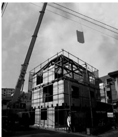
図3 LWB 阪東橋 鉄骨にパネル化したLVL 外壁を取り付ける
