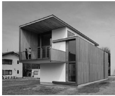
図4 つくばCLT実験棟 大きく3.0m跳ね出した南側のテラスが特徴的な外観
