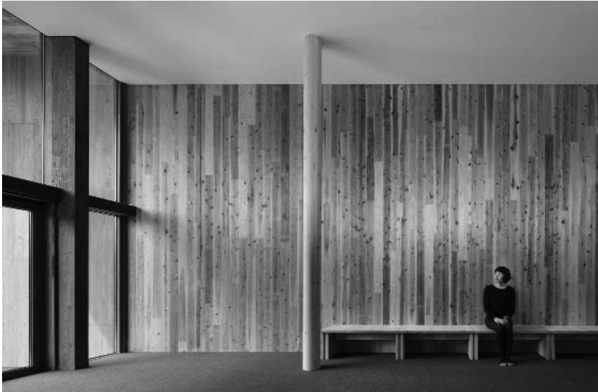
図7 つくば CLT 実験棟のリビング空間、CLT によるシームレスな木質壁
