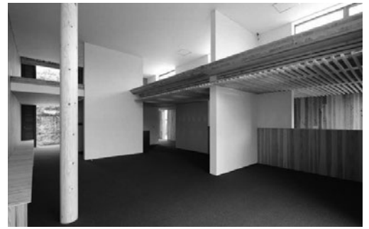
図5 つくばCLT実験棟の内観 CLTによる高い天井空間を実現した
