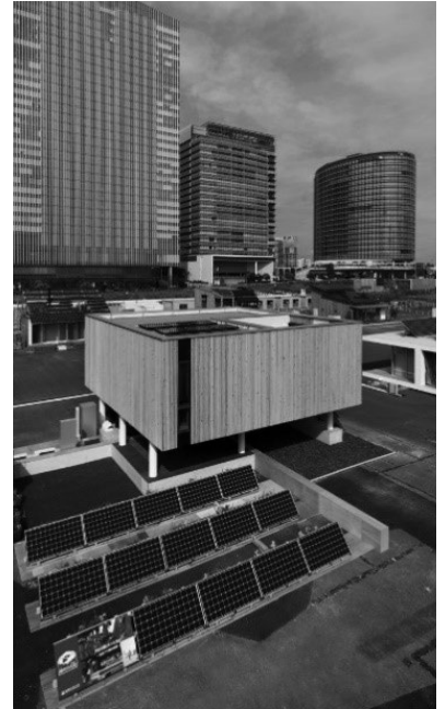
図8 継ぎの住処の外観 1階がピロティとなって居住空間が浮いている
