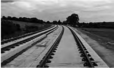
図1 5年前に Gisors-Serqueux 間の新線に建設された新型 NBT 軌道
